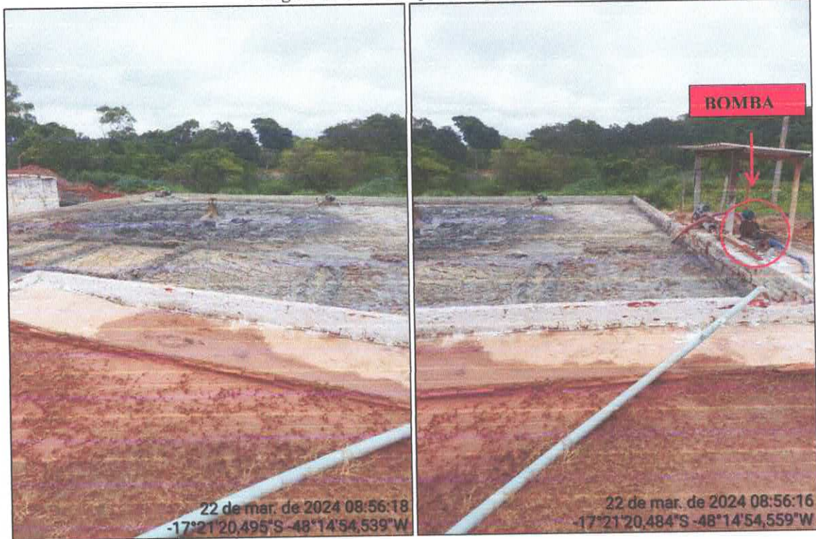
Imagem 10 e 11. Tanque de Equalização.
