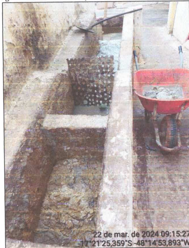
Imagem 3. Peneiras de retenção de restos da limpeza dos couros.
