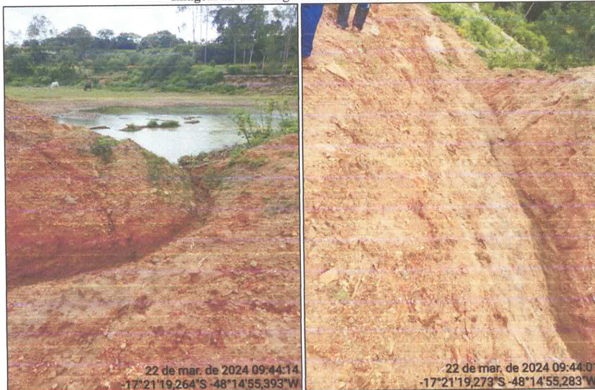
Imagem 22 e 23. Lagoa desativada e canaletas.
