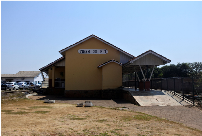
Fig. 1: Estação Ferroviária de Pires do Rio
